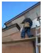
外壁は防災上の指摘もあり、防火に強い材料で外壁をぐるりを貼り付けています。現在の外壁は板張りで、万が一、火災が発生したらすぐに燃えてしまう心配から、市の方に助成金の申請を行い2年がかりで現在工事をしています。
